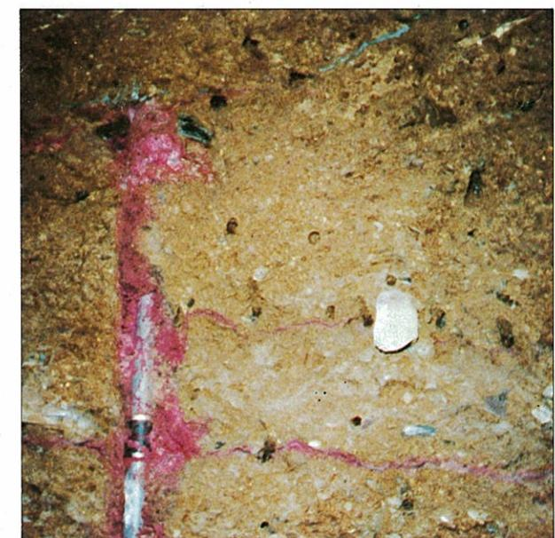
トンネル坑口附近における崖錐層への注入状況
