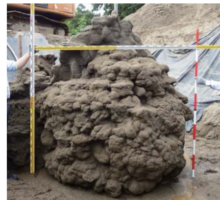
Newスリーブ注入工法の改良体
